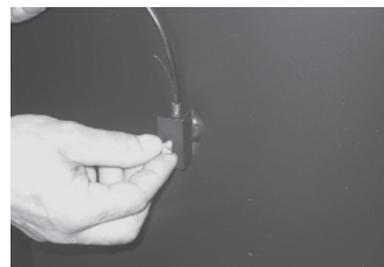
6. Entsprechend den Speicher-Anschlüssen und dem Lochbild der Stützen die Seitenteile (a) deckungsgleich am Speicherkörper anlegen.
