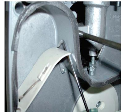
Es kann ein Einstellmaß für die Eintauchtiefe des Brenners von 60 mm angenommen werden. Der Wert wird am Brennerrohr, an der Vorderkante des Rohrhalters abgelesen.
