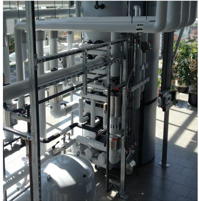
Abb.: CAPITO 3-Zonen-PD 5000 mit Gaskessel, Heizentrale REHAU AG
