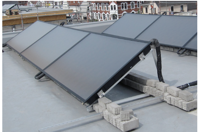
Abb.: CAPITO Solaranlage mit 6 Flachkollektoren CC PCW 252
