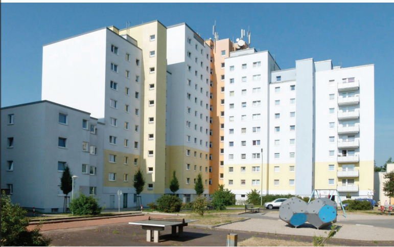
Abb.: Gebäudekomplex mit 101 Wohneinheiten in Würzburg
