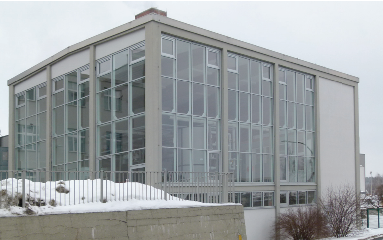
Abb.: Heizzentrale Werk 3 Scandium REHAU AG
