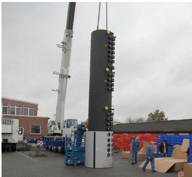
Abb.: Einbau erfolgte aufgrund der Größe der 6 Pufferspeicher mit Hilfe eines Krans durch das Dach des Gebäudes
