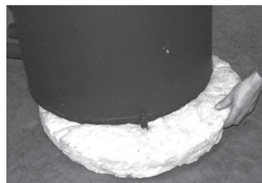
4. Wärme-Zentrale mittels 3 Flach-Rundschrauben (Stellschrauben) ausrichten.
