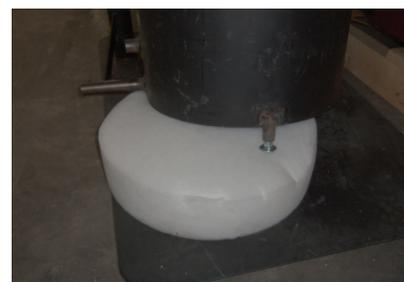
4. Wärme - Zentrale mittels 3-Flach-Rundschrauben (Stellschrauben) (8) ausrichten.
