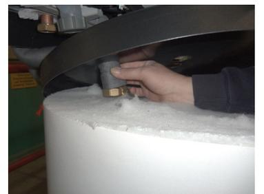
11. Rosette (h) aufstecken und Entleerungshahn eindichten. Anlage füllen und in Betrieb nehmen.
