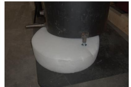
4. Wärme - Zentrale mittels 3-Flach-Rundschrauben (Stellschrauben) (8) ausrichten.
