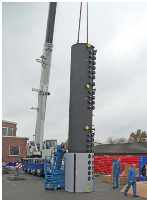
Der Einbau erfolgte aufgrund der Größe der sechs Speicher mit Hilfe eines Krans durch das Dach des Gebäudes.
