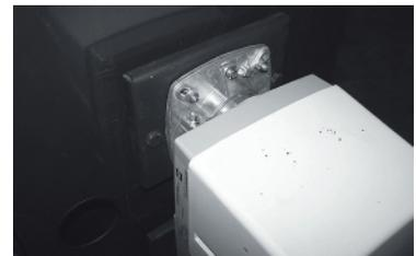
Den Heizöl- bzw. Gasbrenner an Versorgungsleitungen anschließen.
