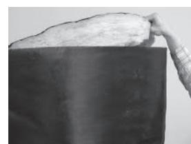
Die größeren Isoliermatten-Deckel oben auf die Isolierung auflegen.
