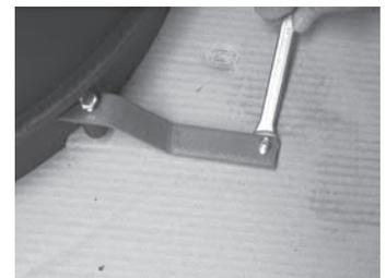
**Achtung:** Um die Montage des Kondensatsiphons beim Brennwertkessel CC 271 BW zu erleichtern, wird empfohlen die Stellschraube "a" um bis zu 10 mm rauszudrehen.
