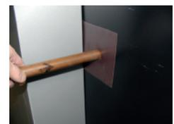
Bei der Montage der Schalldämmhaube - insbesondere bei raumluftunabhängiger Betriebsweise- darf die Dichtfläche (4) rundrum nicht beschädigt werden.
