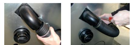
Bei Gaskessel: Schlauch des Druckluftwächters
