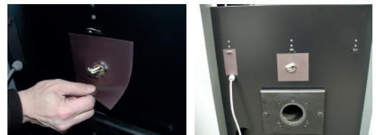
Trinkwarmwasserfühler in Tauchhülse (Seite 7-9, Pos. 2) einführen. Kesselfühler in Tauchhülse (Seite 7-9, Pos. 5b) einführen. Damit ein späteres Herausziehen der Fühler verhindert wird, muss der beiliegende Kunststoff-Sternclip in die Tauchhülsen eingesteckt werden.
