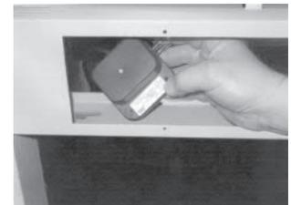
Der Druckwächter wird lose in die Ausstanzung der Regelungskonsole links positioniert. (Nur bei Gas-Brennwertkesseln).
