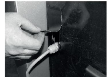
Die 4 Fühler bzw. Kapillare durch den Ausschnitt in der Vorderwand führen und gebündelt in die Kesseltauchhülse (Seite 6, Pos. 5) einstecken. Danach den beiliegenden Kunststoff-Sternclip in die Tauchhülse einstecken, damit ein späteres Herausziehen der Fühler verhindert wird. Beim Herausnehmen in umgekehrter Reihenfolge verfahren.
