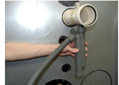
Der Kondensatablaufschlauch ist in Strömungsrichtung fallend an der Neutralisationsbox bzw. dem Abwasserkanal angeschlossen.
