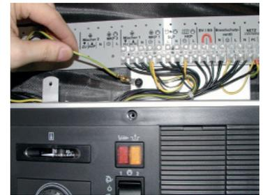
Regelung in den Ausschnitt drücken und mit den 4 Schrauben befestigen.
