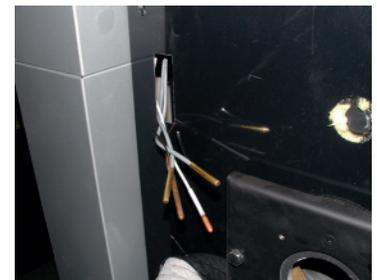
**Achtung:** Bei raumluftunabhängiger Betriebsweise, sind die 4 Leitungen hinter der Vorderwand zu verlegen. Öffnung (1) für die Fühler bzw. Kapillare mit dem beiliegenden gelochtem Magnetstreifen abkleben.
