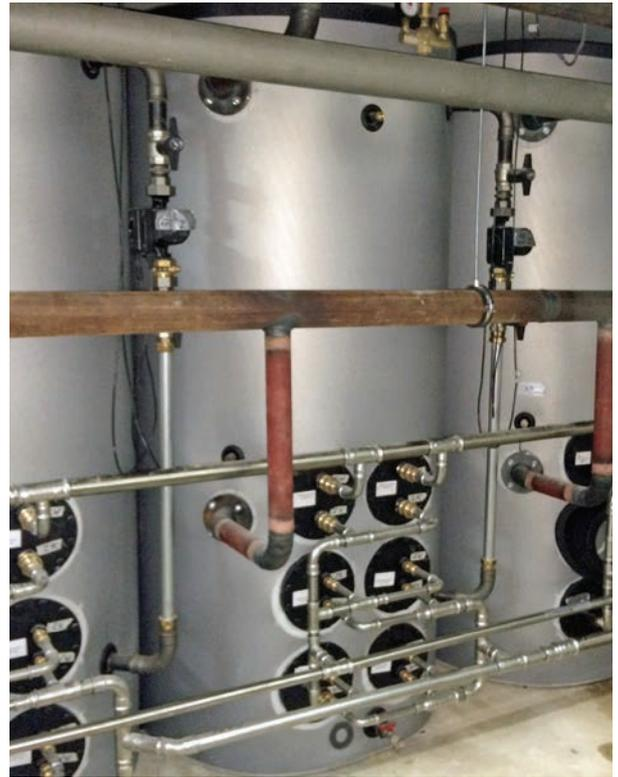
Abb.: Trinkwasseranlage mit 3 CAPITO Pufferspeicher 2-Zonen-PD 750
