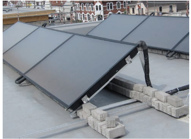
Abb.: CAPITO Solaranlage mit 6 Flachkollektoren CC PCW 252
