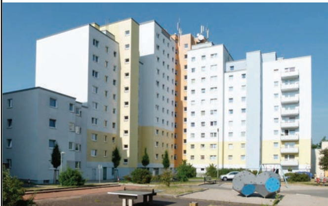
Abb.: Gebäudekomplex mit 101 Wohneinheiten in Würzburg
