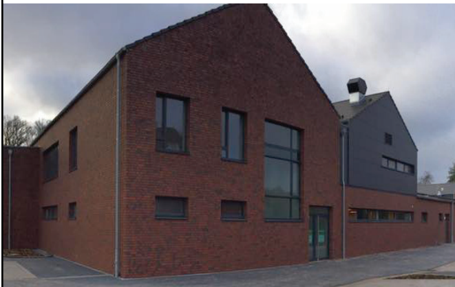
Abb.: neues Feuerwehrgerätehaus in Harsewinkel
