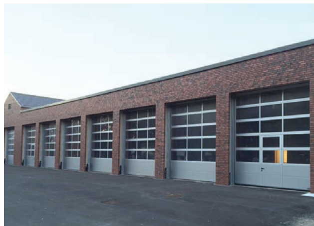
Abb.: Neubau Fahrzeughalle
